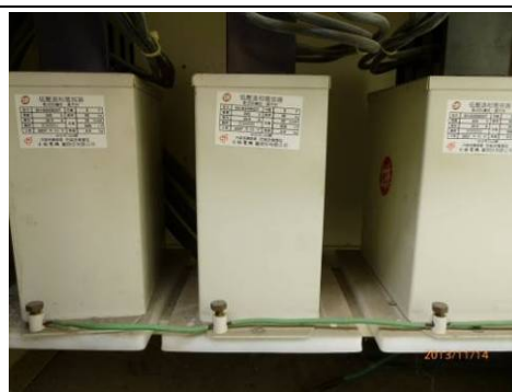
圖二 低壓進相電容器
